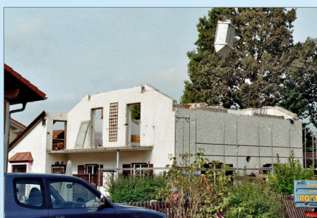
Der alte Dachstuhl wird abgenommen, das Haus entkernt.
