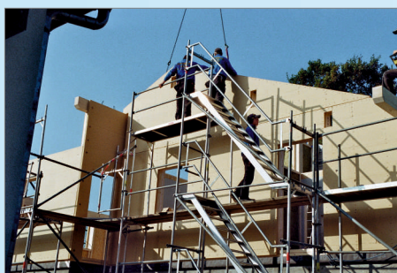
Montage des neuen Obergeschosses.
