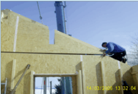
Montage des neuen Obergeschosses.
