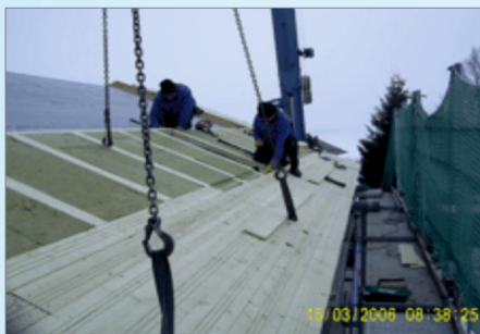
Montieren & dämmen des Außendaches.
