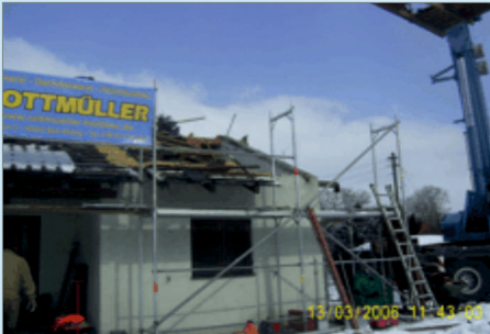
Der alte Dachstuhl wird zurückgebaut.
