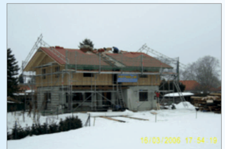
Die Arbeiten sind fast abgeschlossen.
