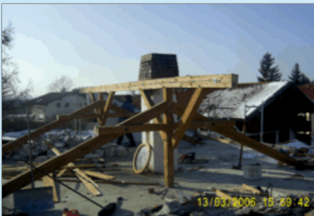
Der Rückbau ist fast abgeschlossen.
