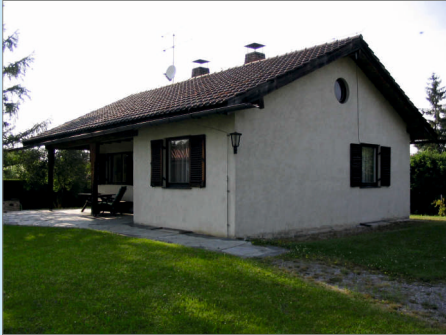
Urzustand des Hauses
