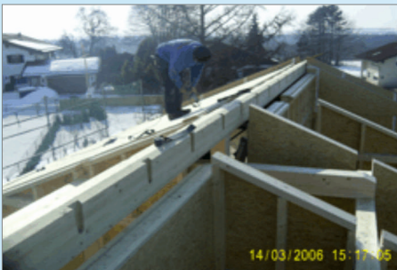
Montage des neuen Dachstuhls hat begonnen.
